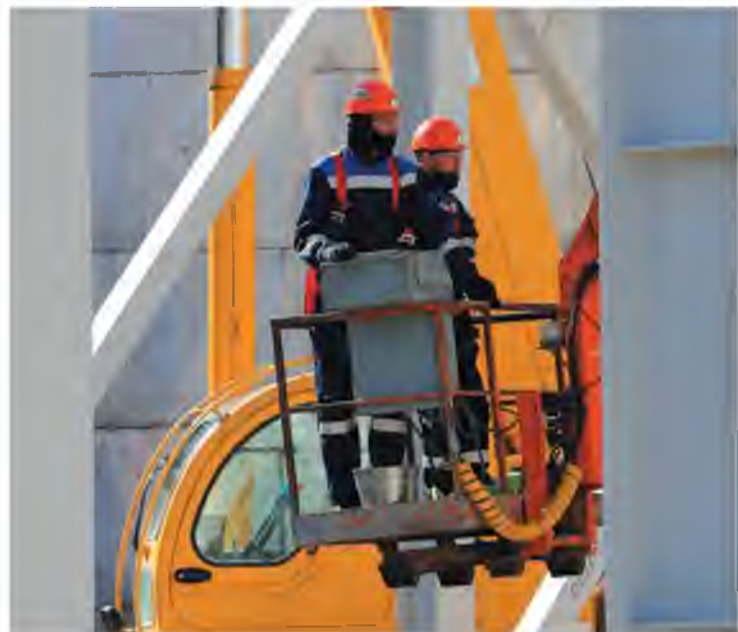
На объекте №542, который после завершения строительства будет называться градирней, монтируют металлоконструкции
