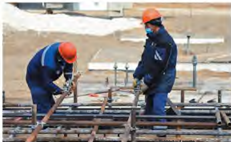
На объекте №506/3 (будущая паровая котельная) идёт армирование ростерков под оборудование
